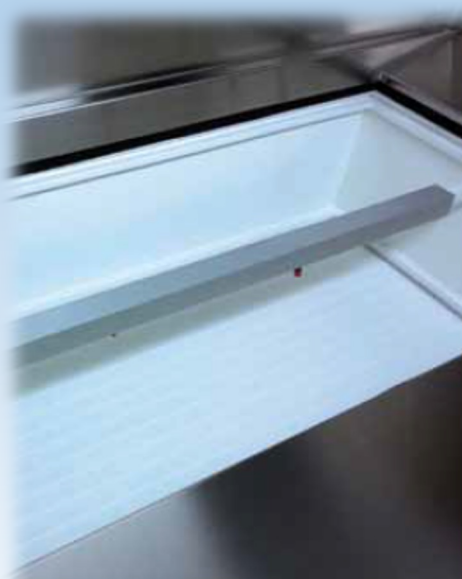
Filtro ULPA in fase di lavoro. Gli ugelli di colore nero posti sulla barra orizzontale nebulizzano la soluzione incapsulante
